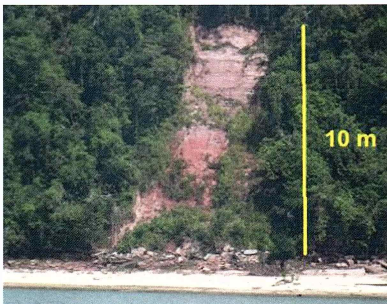
Figura 18: Escorregamento nas margens do rio Tapajós.
